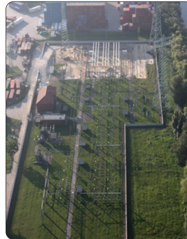
Freiluftschaltanlage des Umspannwerks NeuhoF in Hamburg-Wilhelmsburg
